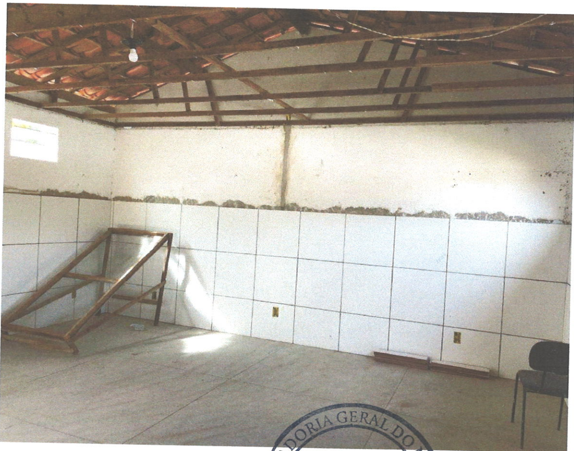
FOTO 10 EXECUÇÃO DE REVESTIMENTO CERÂMICO DA SALA MULTIMÍDIA
