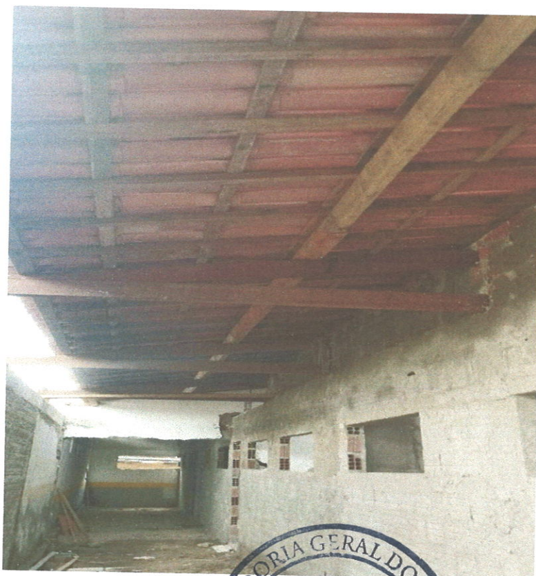
FOTO 08 EXECUÇÃO CHAPISCO NO CORREDOR
