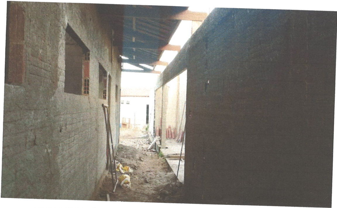
FOTO 01 EXECUÇÃO DE ALVENARIA E CHAPISCO DA AMPLIAÇÃO DA ESCOLA
