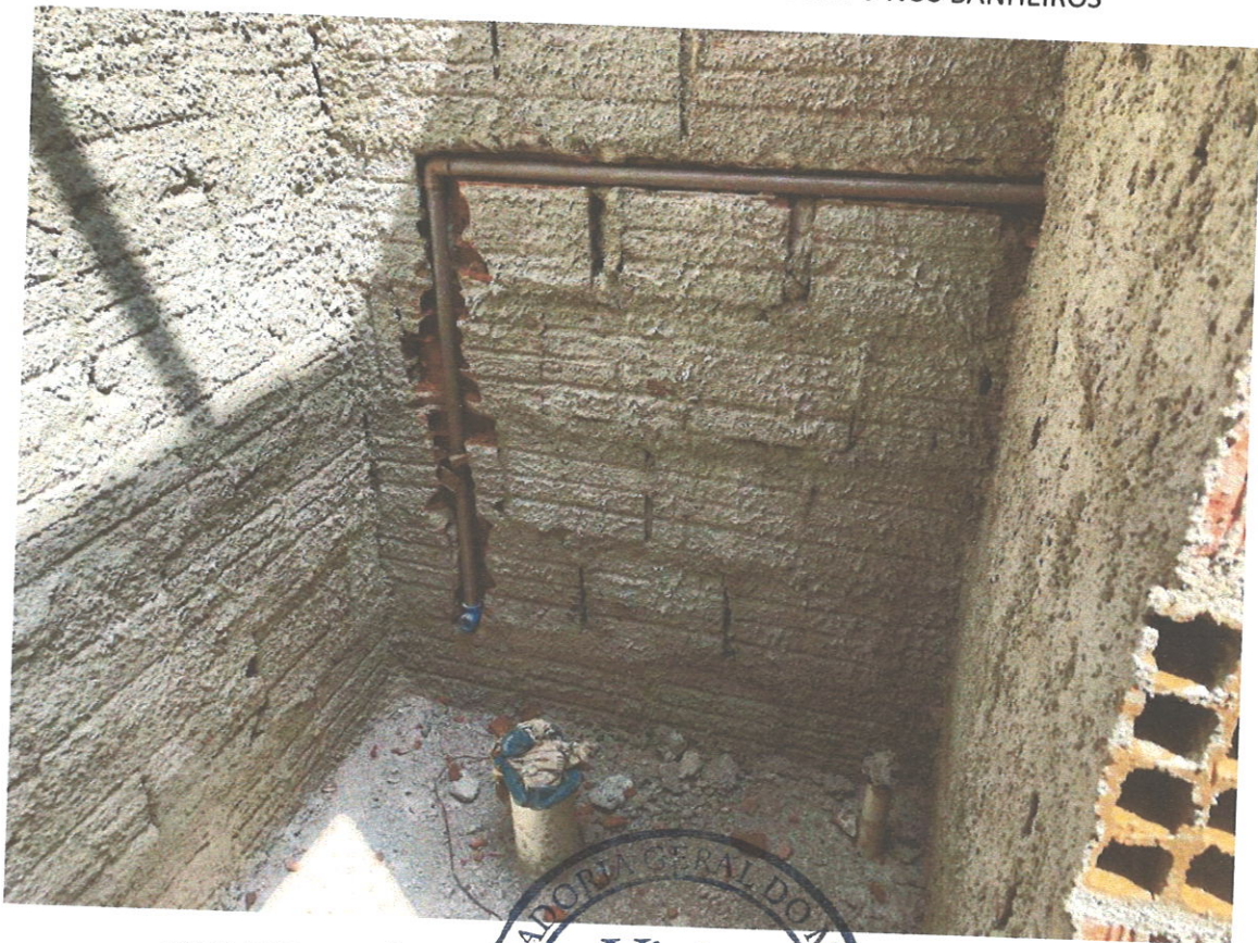
FOTO 15 EXECUÇÃO DE PONTOS DE AGUA E ESGOTO NOS BANHEIROS
