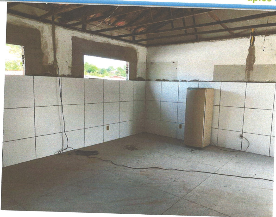
FOTO 11 EXECUÇÃO DE REVESTIMENTO CERAMICO DA BIBLIOTECA
