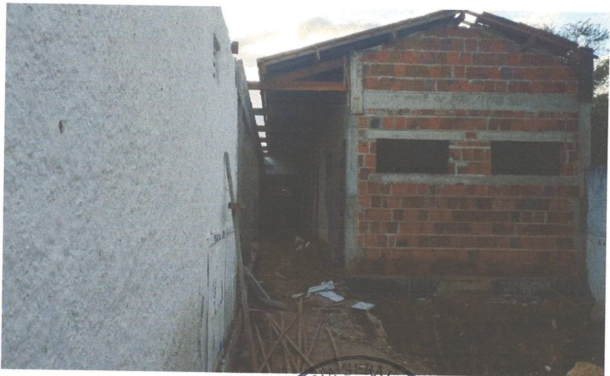
FOTO 06 EXECUÇÃO DE TELHADO DA AMPLIAÇÃO DAS SALAS DE AULA E CORREDOR
