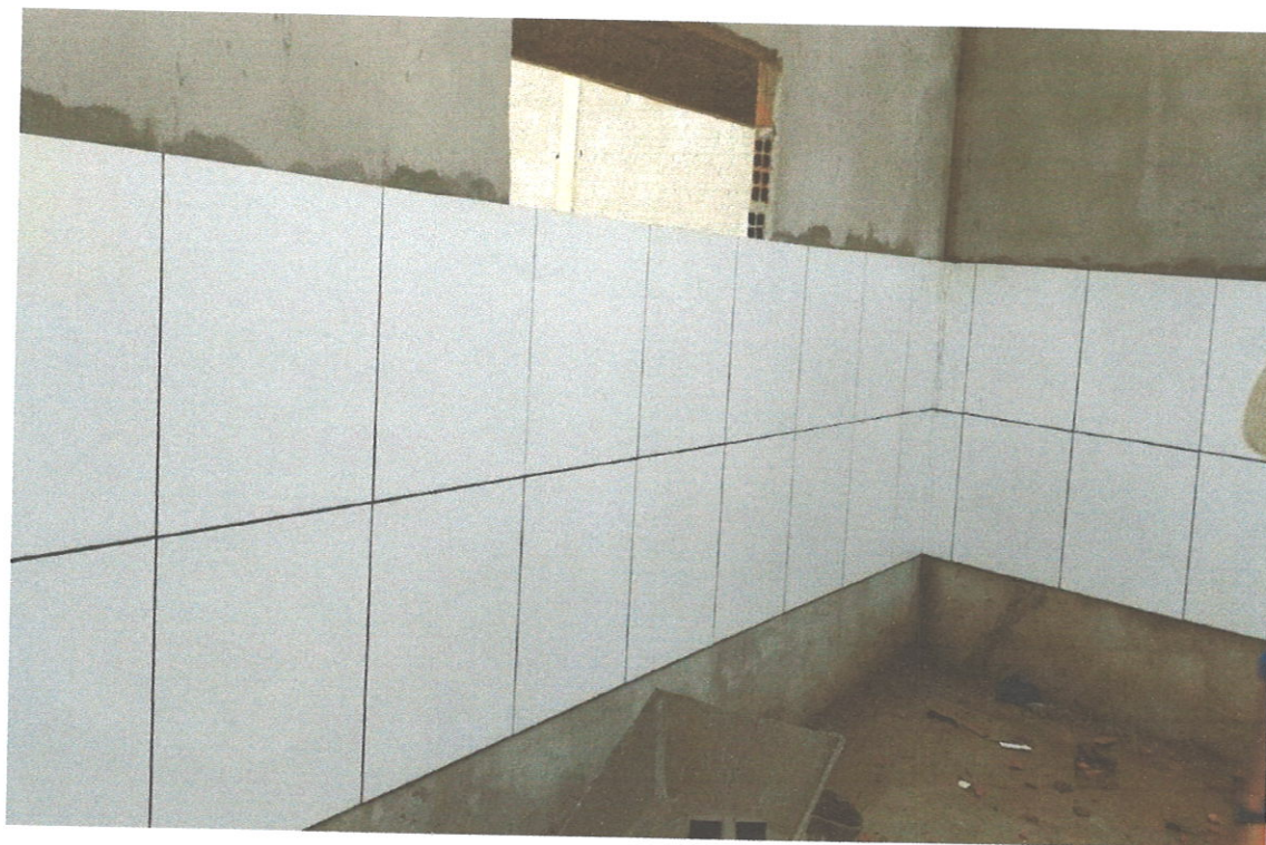
FOTO 07 EXECUÇÃO DE REBOCO E REVESTIMENTO CERAMICO NA SALA DE AULA
