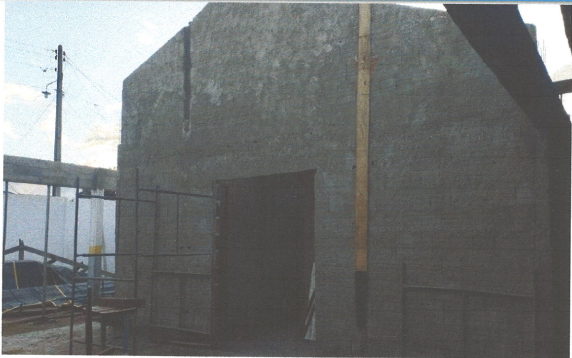
FOTO 03 EXECUÇÃO DE ALVENARIA E CHAPISCO DOS BANHEIROS DOS ALUNOS
