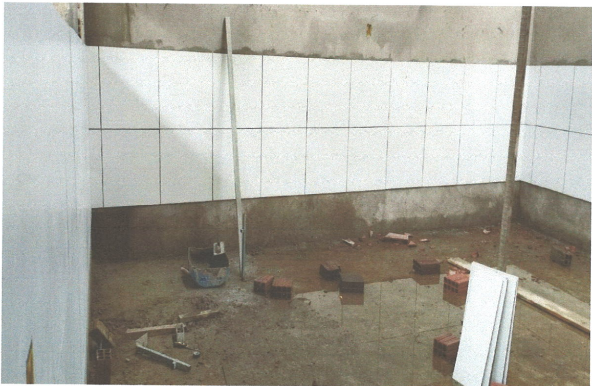
FOTO 04 EXECUÇÃO DE REBOCO E REVESTIMENTO CERAMICO NAS SALAS DE AULA DA
