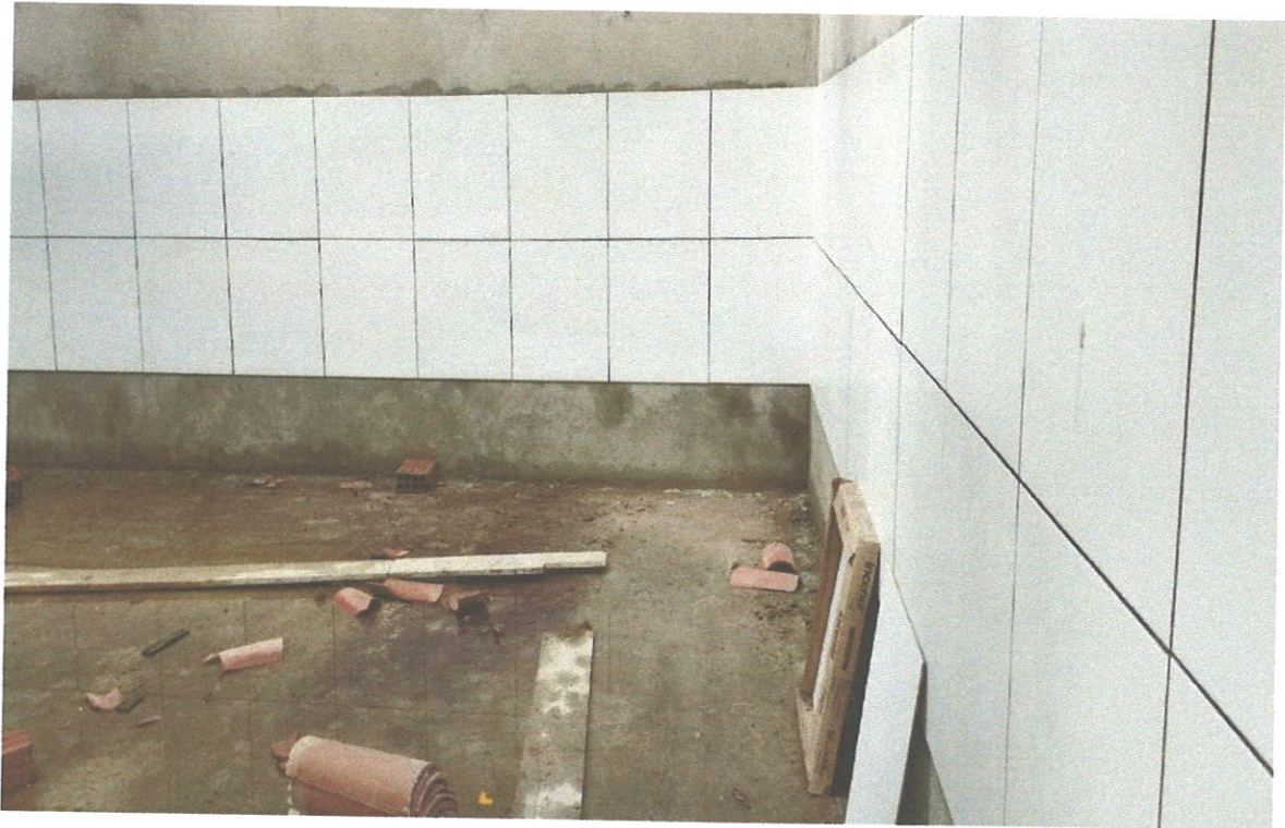
FOTO 05 EXECUÇÃO DE REBOCO E REVESTIMENTO CERAMICO NAS SALAS DE AULA DA AMPLIAÇÃO
