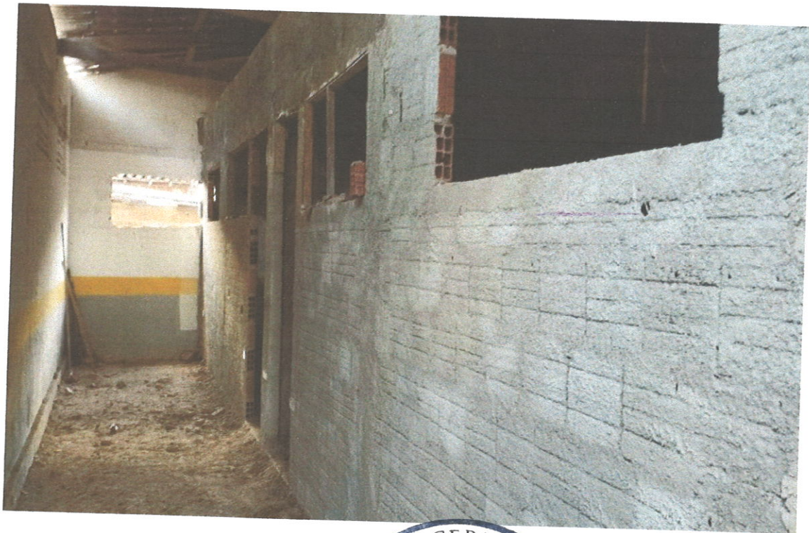
FOTO 02 EXECUÇÃO DE ALVENARIA E CHAPISCO DAS SALAS DE AULAS
